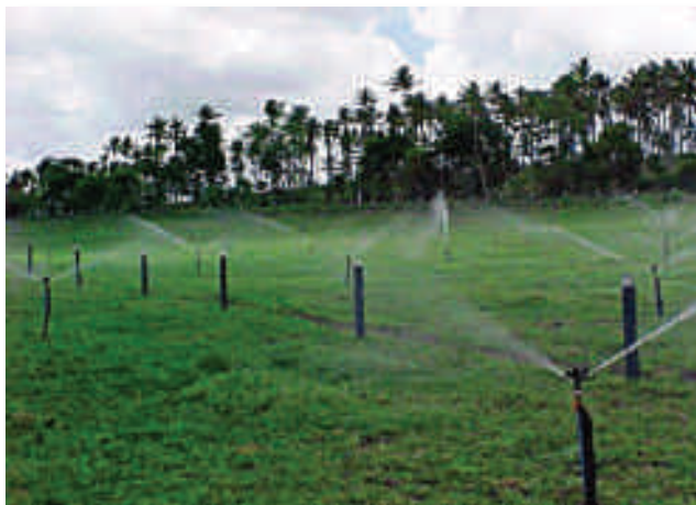
Figura 22 - Sistema de Aspersão fixa
