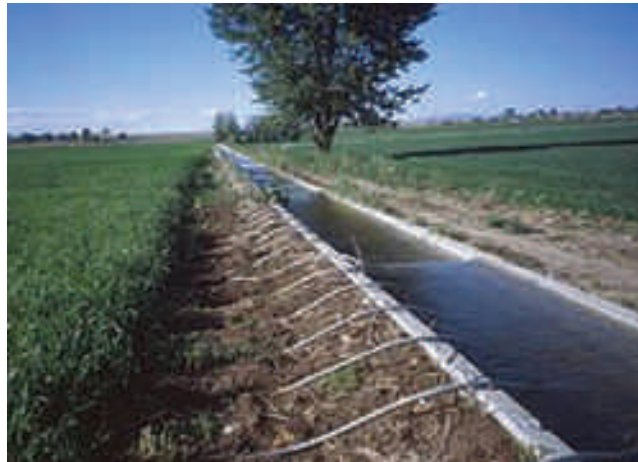
Figura 4 - Canal de irrigação com sistema de sifão
