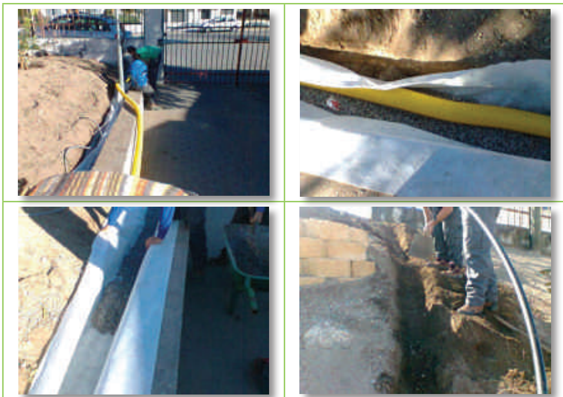
Figura 39 - Fases da instalação do sistema de rega e de drenagem
