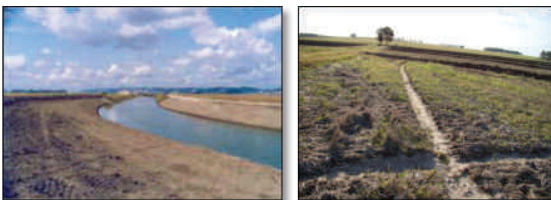
Figura 28 - Valas de drenagem superficial
